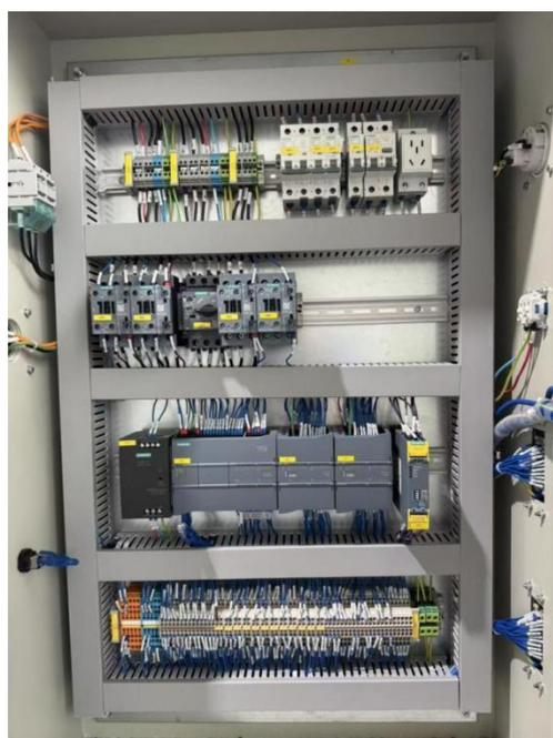
开关电源、S7-1200 可编程逻辑控制器、数字量拓展模块、安全继电器、触摸屏、带灯按钮、急停按钮、两位、三位旋钮。控制柜上电顺序应符合规范“负荷开关-QF2-QF3-QF4-QF5”。
